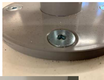
Zapuštění kotevního šroubu v patce
